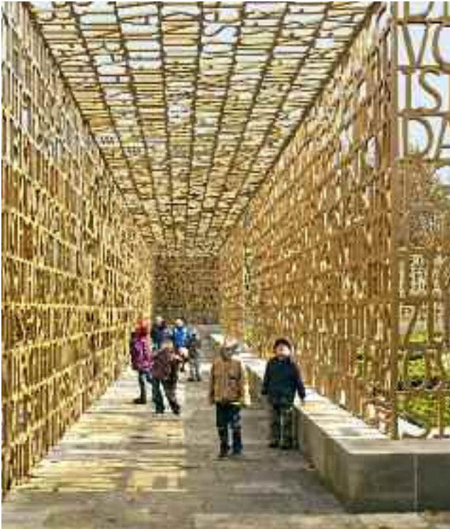
Im Wandelgang des Gartens sind Schriftzeichen (Typographie und Satz: xplicit) nicht nur konzeptionell das tragende Element. Sie bilden eine selbsttragende Konstruktion (Tragwerk: schlaich bergemann und partner).
