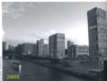
Demolición del Palacio de la República Demolition of the Palast der Republik
